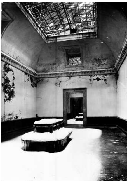
Behavazott első emeleti terem az ostrom után
