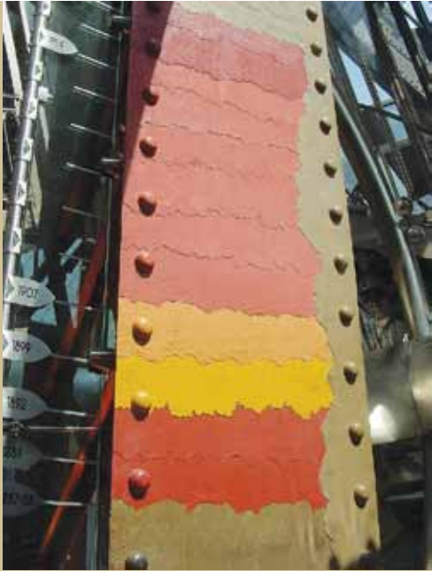
Festékrétegek az Eiffel-tornyon évszámokkal
