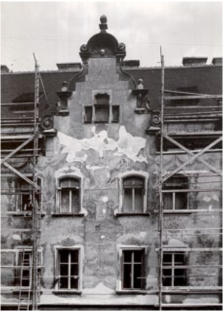
A Baross utcai ház felállványozott homlokzata az 1930-as években
