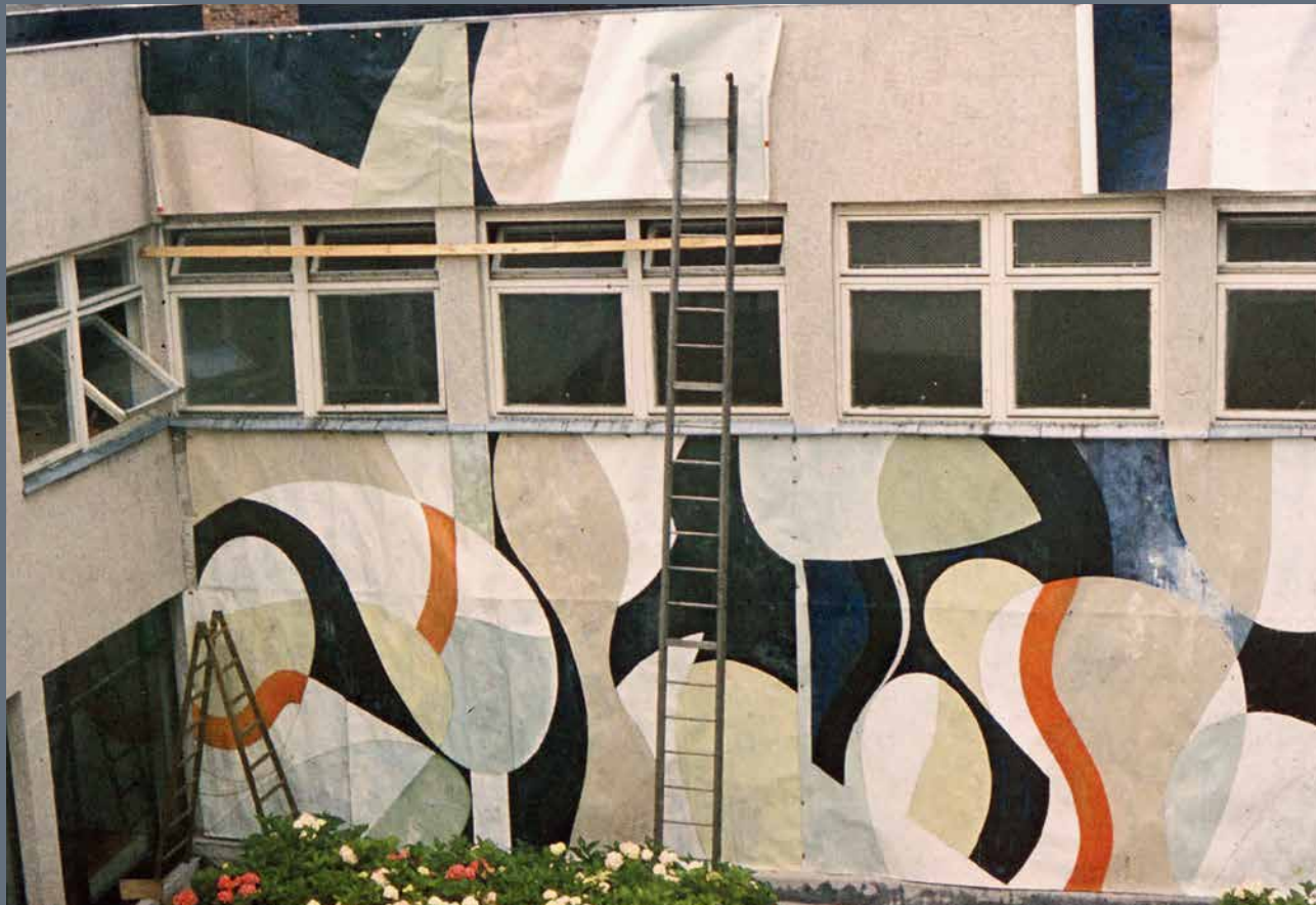
Archív fotók a Főnix kompozíció beépítését megelőző munkálatokról, Sátoraljaújhely
