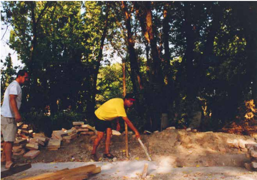
Birkás Ákos falíveket rajzol ki Ekler Dezső családi házának építkezésén, 1992
