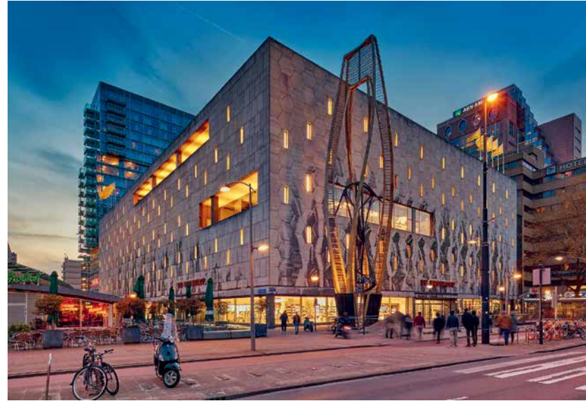
A Breuer tervezte épület a 2019-es homlokzati felújítás után, fotó: © de Bijenkorf
