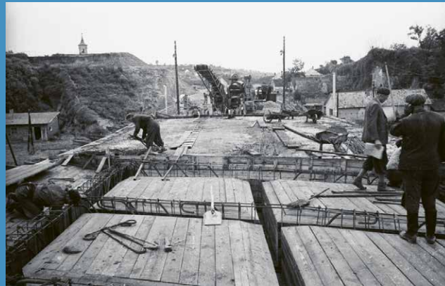
Fent: (Dunapentele) Vasúti felüljáró átépítése a Magyar útnál. Háttérben az 1941-ben felavatott O.N.CS.A. – Gróf Teleki Pál-telep, 1949 © Fortepan, UVATERV
