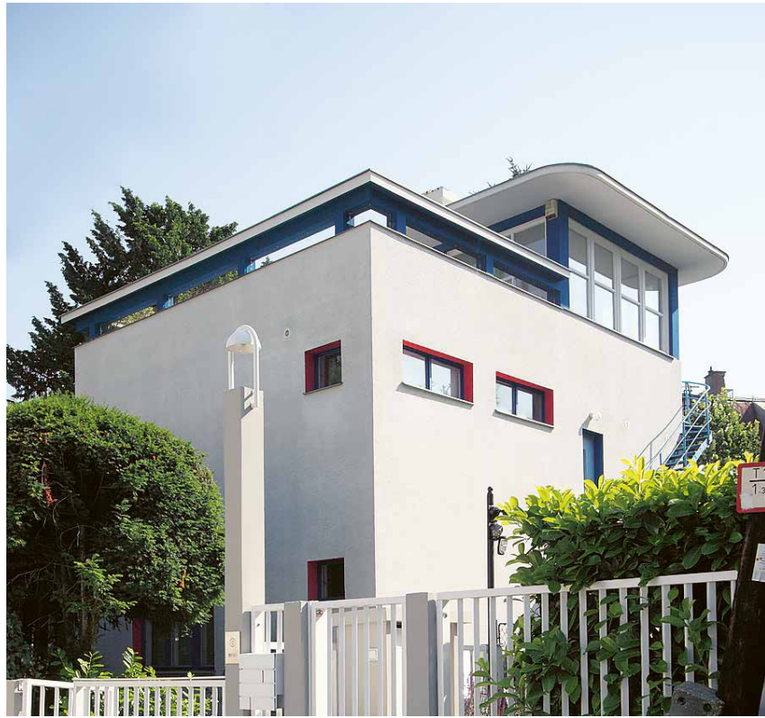
Fischer József helyreállított épülete a Napraforgó utca 20. szám alatt, 2019
