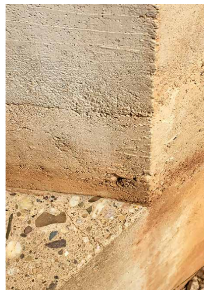
Az épület hibátlan élei, az egymásba hullámszó, körülbelül ötven centiméteres, szabálytalanul vízszintes betonrétegek és a kívülről látott krómácel csövek belső végződését záró üveggömbök
