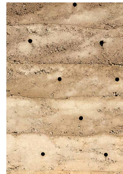
Az épület hibátlan élei, az egymásba hullámszó, körülbelül ötven centiméteres, szabálytalanul vízszintes betonrétegek és a kívülről látott krómácel csövek belső végződését záró üveggömbök
