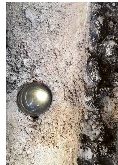
Az épület hibátlan élei, az egymásba hullámszó, körülbelül ötven centiméteres, szabálytalanul vízszintes betonrétegek és a kívülről látott krómácel csövek belső végződését záró üveggömbök
